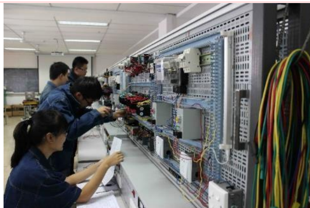
电工技能实训室
